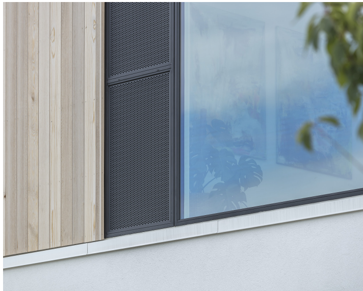
SPECIALLØSNING // NATURLIG VENTILATION
